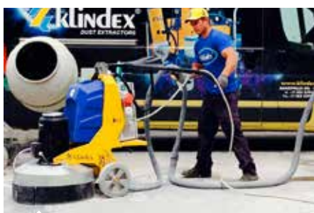
Auch für schwere Arbeiten geeignet
