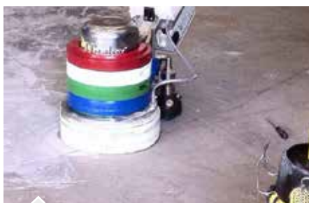
Schleifen von Beton
